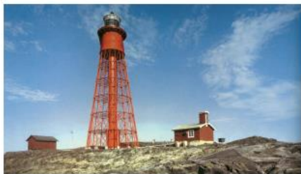
Obr. 3. Jedna z prvních švédských konstrukcí s duplexním povlakem – Maják Pater Noster (v roce 1868 byl zároveň pozinkován a potom byl aplikován nátěrový systém) [9].
