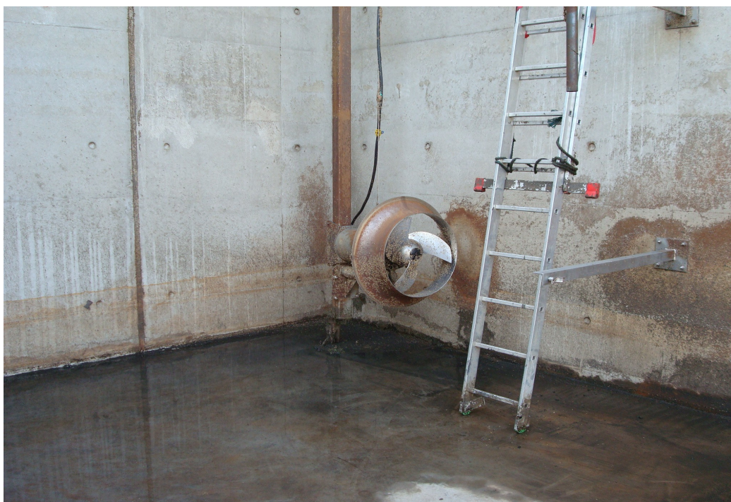
obr.13. Míchadlo ČOV Brno MOdřice
