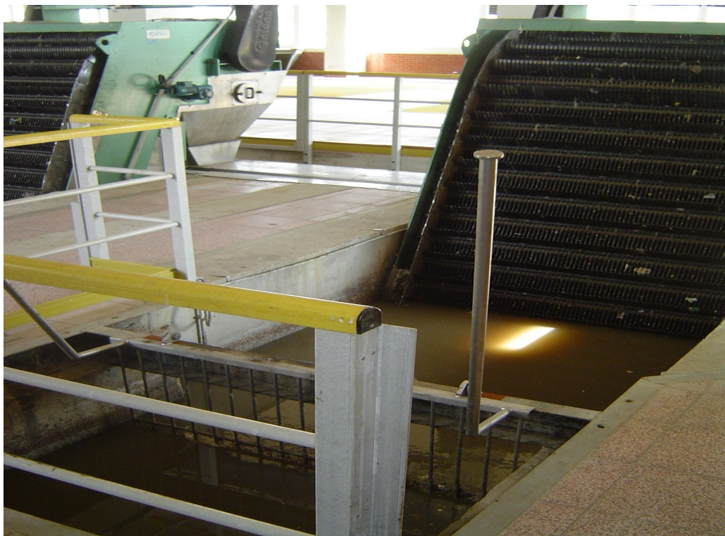
obr.3. Hrubé a jemné česle (pohled z předu)-ČOV Brno Modřice
