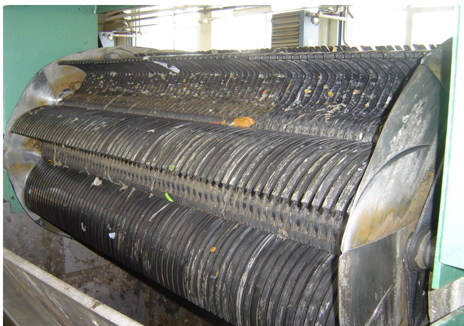
obr.4. Česle(pohled zezadu) ČOV Brno Modřice
