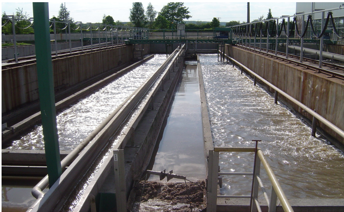
obr.5. Lapáky písku ČOV Brno Modřice
