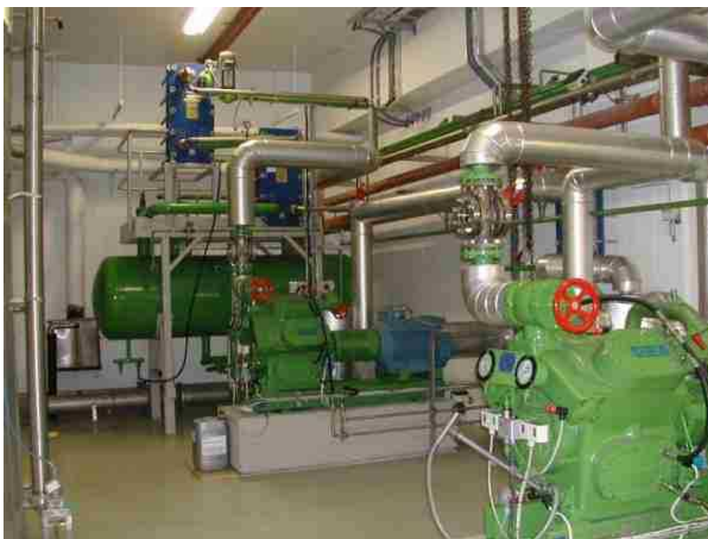
Obr. 2.1 – úspěšně provozované HTC v mlékárenském provozu v Norsku – převzato z [5]
